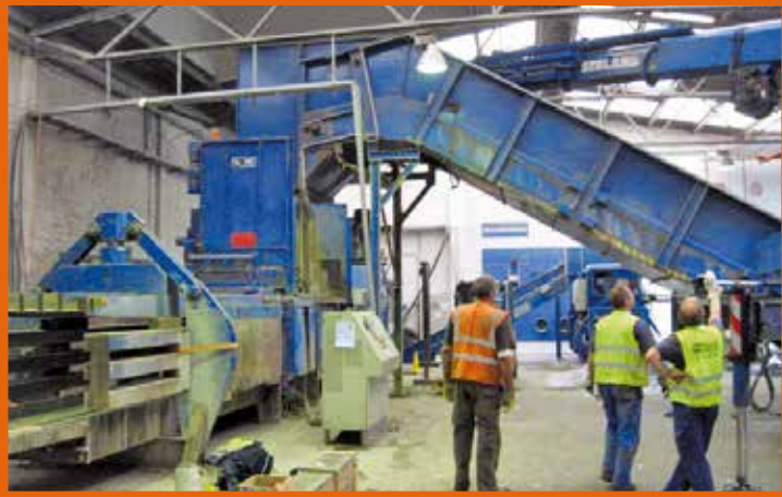
Demontage des Kettenband bei sehr geringer Deckenhöhe durch Spezial-Kranausleger
